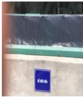
Bể điều hòa
