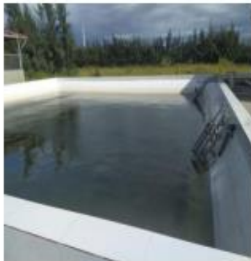
Bể chứa NT sau xử lý có quan trắc nước thải tự động
