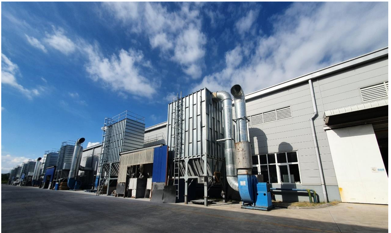
Hình 3.6. Hình ảnh 10 hệ thống xử lý bụi từ máy cắt tấm, tạo hèm (máy làm chốt)
