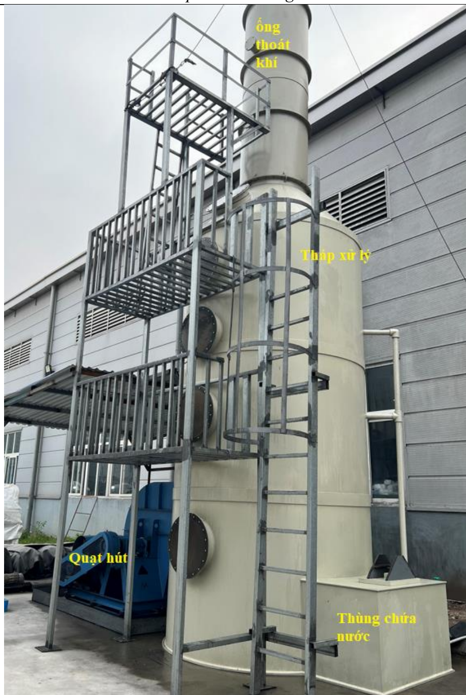
Hình 3.13. Hệ thống thu gom khí thải từ dây chuyền sản xuất lớp cốt SPC (lớp 5)
