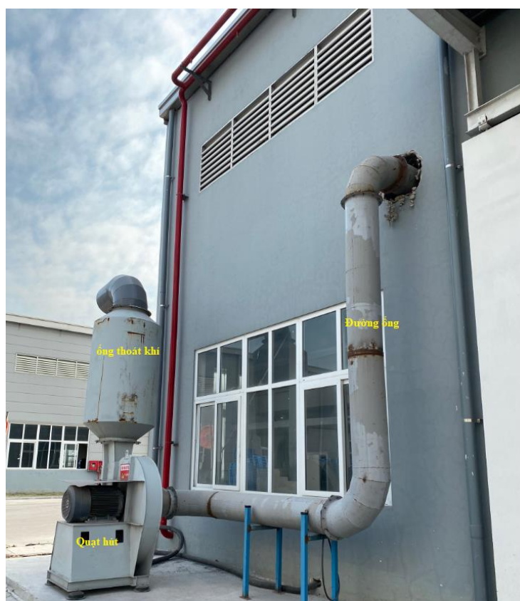
Hình 3.8. Hình ảnh hệ thống thu gom, xử lý bụi từ máy nghiền
