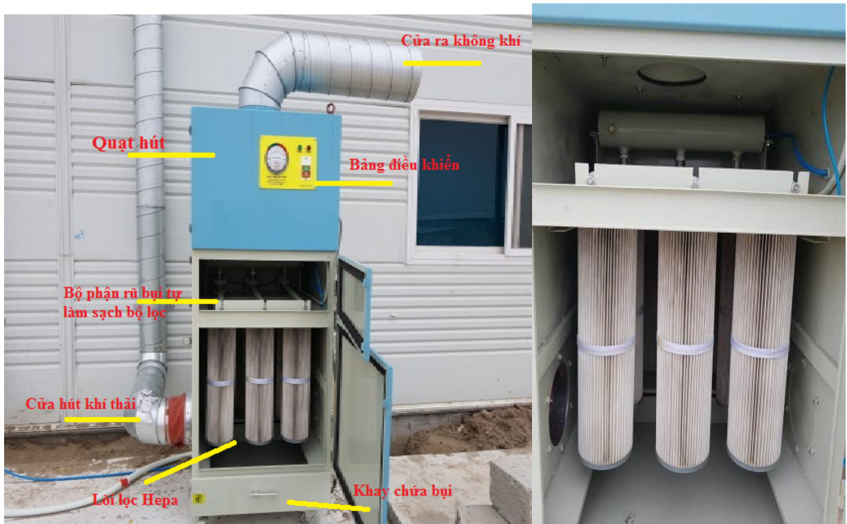
Hình 3.5. Hình ảnh hệ thống lọc bụi
