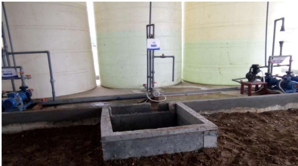
Hình 3. 17. Hồ gas thu gom ở kho hóa chất xử lý nước thải
